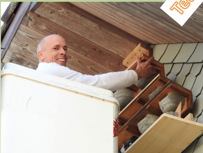
Michael bei der Montage am neuen Standort. Danke auch an die TBG!
