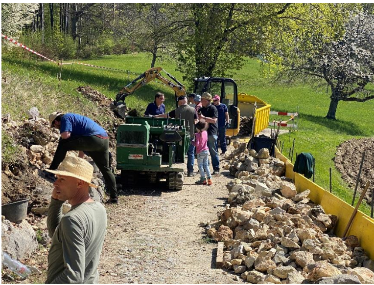
Die Steine wurden von Hand abgebaut, damit möglichst keine Tiere verletzt wurden. Bollensteine wurden gesammelt und entfernt.
