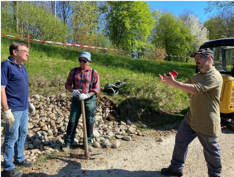
Adrian (links) und Giorgio erhalten Instruktionen von Trockensteinmauerprofi und Baustellenleiter Beat Utiger.
