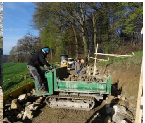
Jeder Stein wurde behauen und passend gemacht. Die linke Ecke hatte schon bald die Endhöhe erreicht.
