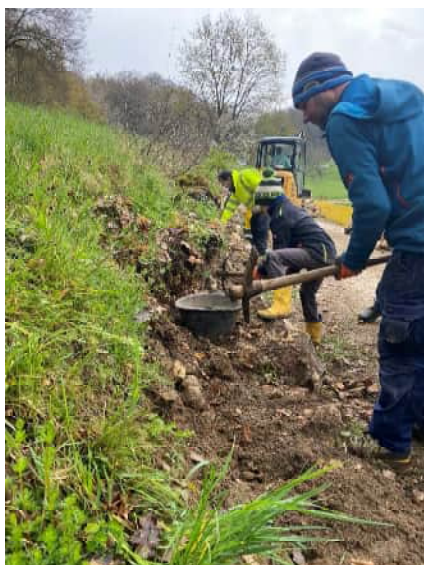
Abbau der alten Mauer
