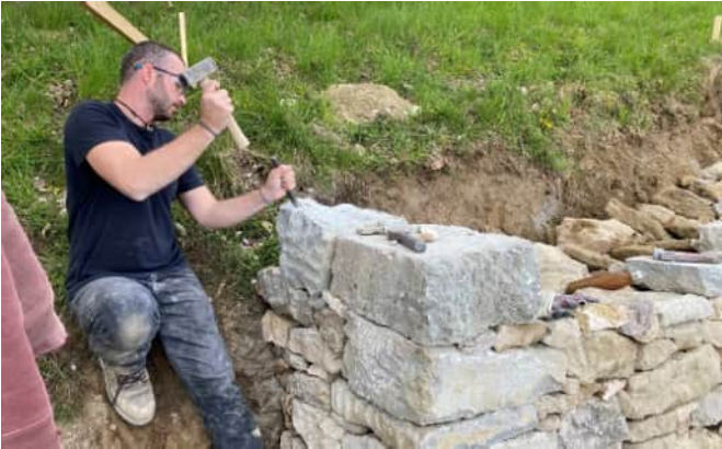
Jeder Stein wurde behauen und passend gemacht. Die linke Ecke hatte schon bald die Endhöhe erreicht.
