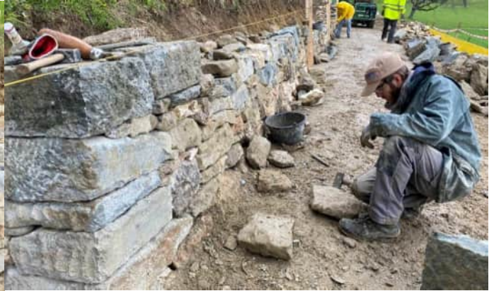
Jeder Stein wurde behauen und passend gemacht. Die linke Ecke hatte schon bald die Endhöhe erreicht.
