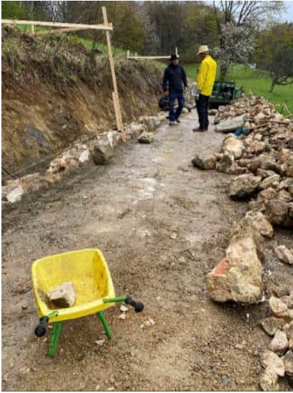
Am Tag 2: Die Profile sind gestellt und das Mauern beginnt.
