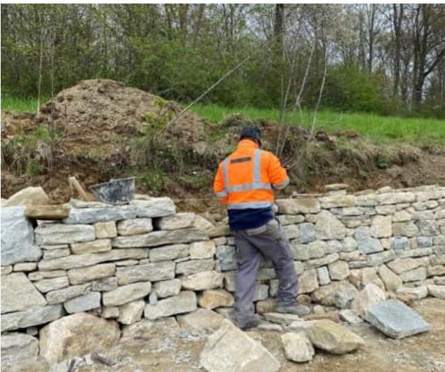
Die Mauer wird geschlossen.
