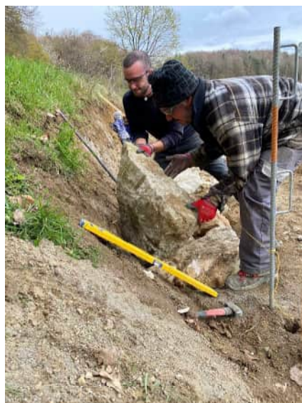
Erste Fundamentsteine wurden gesetzt.
