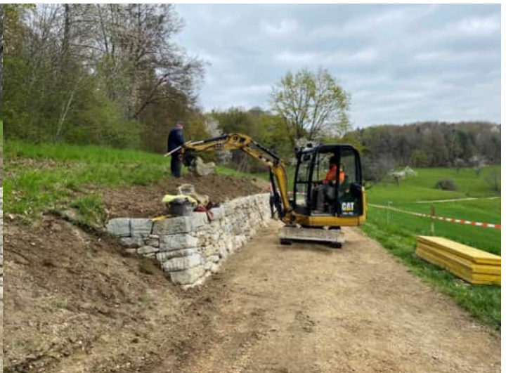
Letzte Arbeiten und danach ging's ans Aufräumen und Putzen.
